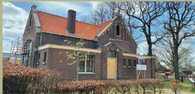
Foto werkzaamheden Oude Gracht 2
